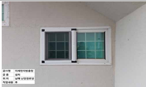
안전바, 좌식마루, 나노방진망 설치 사진
